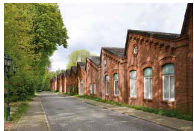
Die Sheddächer der ehemaligen Industrieanlage prägen noch heute die Architektur auf dem Nordwolle-Gelände
