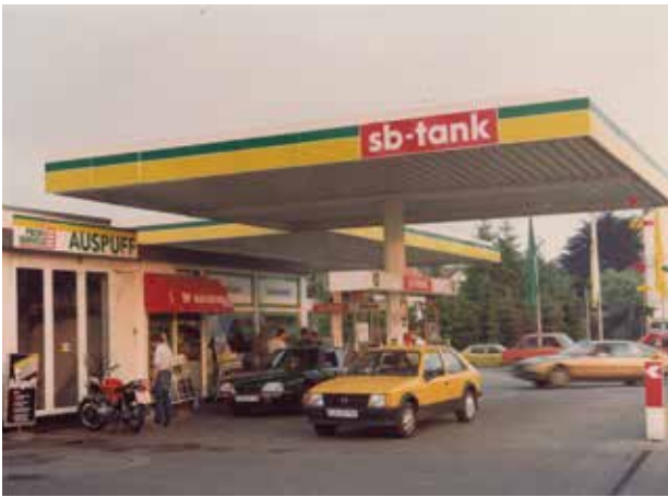
Soestenstraße. SB Tankstelle Karl Knoop 1977. Im Jahre 1979 wurde diese um eine moderne automatische Waschanlage erweitert.
